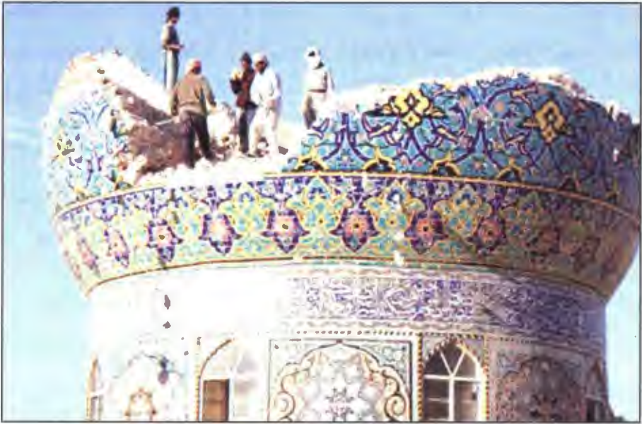
قبة مرقد الحر الأثرية أثناء الهدم
