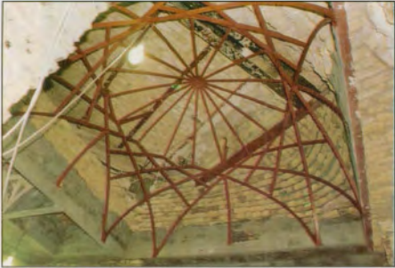
سقف المذبح والهيكلة الحديدي المعمول لبناء المقرنصات والمرايا
